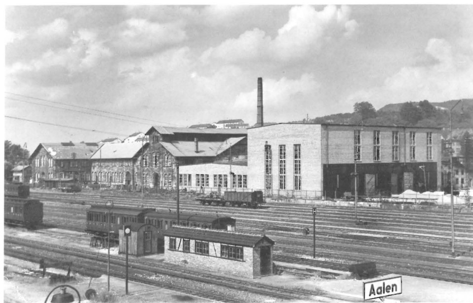
Das Ausbesserungswerk Aalen, zuerst Reparatur-Werkstätte für Lokomotiven und Wagen, dann Hauptwerkstätte; Flügel IV und V wurden in etwas geänderter Form nach 1945 wiederaufgebaut (an den rechteckigen Fenstern erkennbar). Aufnahme von 1955 aus Südwesten.
