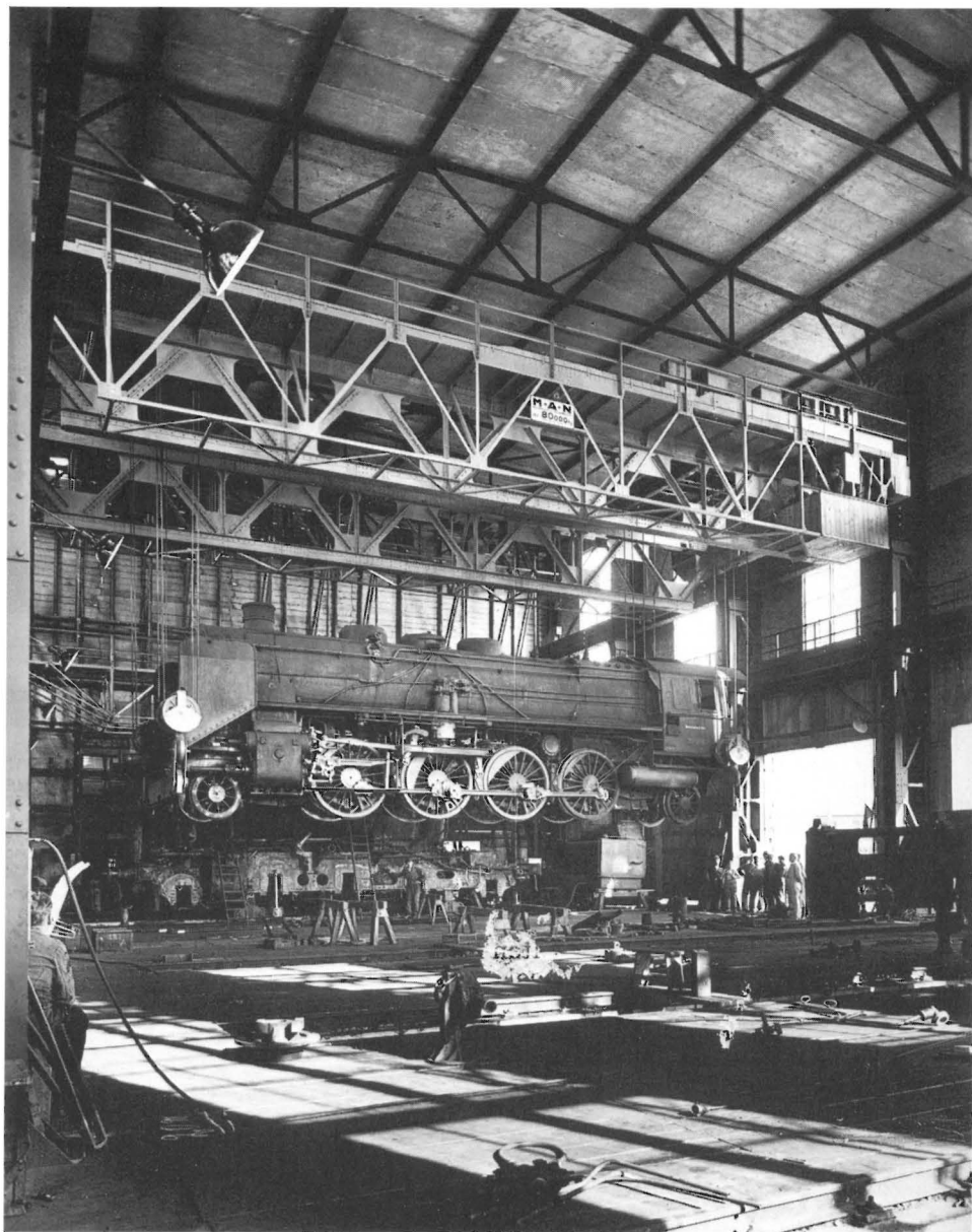
Kranprüfung im Flügel V des Ausbesserungswerkes Aalen. Eine an Laufkatzen hängende schwere Personenzugdampflokomotive der Baureihe 39; diese Maschinengattung gehörte nicht zum Unterhaltungsbestand des AW Aalen, sie war nur zur Kranprüfung nach Aalen beordert worden. Auf dem Hallenboden im Hintergrund liegend der Blechrahmen einer Sächsischen Lokomotive. Aufnahme von 1950.
